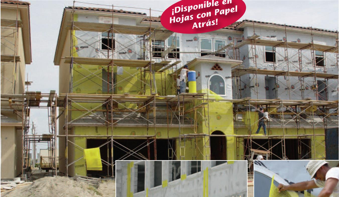
La malla plástica Ultra-Lath Plus™ de Plastic Components es la alternativa para las mallas metálicas, ya que es inoxidable y se ahorra tiempo de instalación. Ahora CUMPLE con la ASTM y viene con la opción de papel impregnado con alquitrán para lograr un control superior de la humedad.
