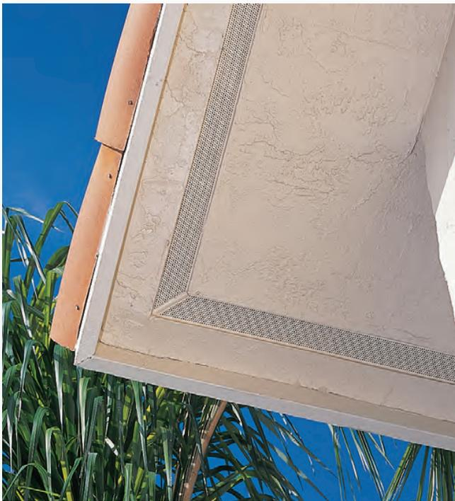
La malla de la fibra de vidrio debe ser superpuesta sobre las alas perforadas y a través de todas las juntas.
