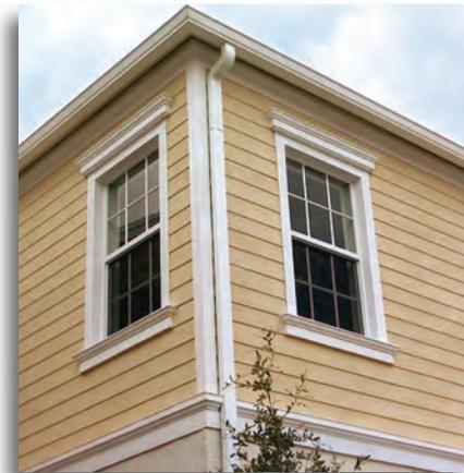
A todas las juntas de tope, intersecciones y terminaciones se les debe aplicar pasta sellante en el momento de la instalación utilizando un sellador elastomérico, como Ultra-Tech™ (PC-ULTW) de Plastic Components.
