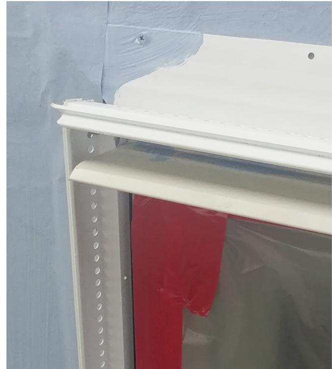
Las molduras exteriores de Plastic Components son resistentes a los rayos ultravioleta y fabricados con compuestos de PVC resistentes al alto impacto y sin plomo, que cumplen con las normas de ASTM D1784 y C1063 (para estuco exterior, una capa, aplicaciones DEFS y EIFS), D1784 (para estuco exterior), D3678 y C1047 (para paneles de yeso interior).
