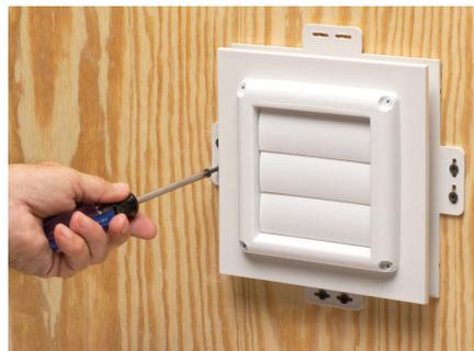
**2** Use tornillos para ajustar los orificios de ventilación al sustrato a través del reborde
