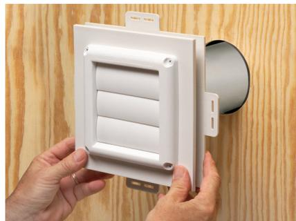
**1** Corte un agujero en el sustrato para obtener una perforación de 4-1/2" con la sierra. Inserte el tubo de ventilación en la abertura.
