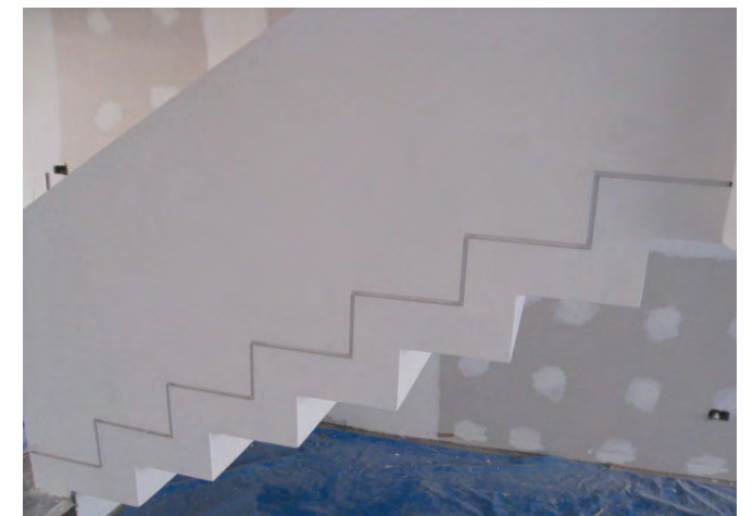
Entrecalle para Paneles de Yeso Estéticos e Intersección de la Entrecalle con un Angulo de 90° en la escalera
