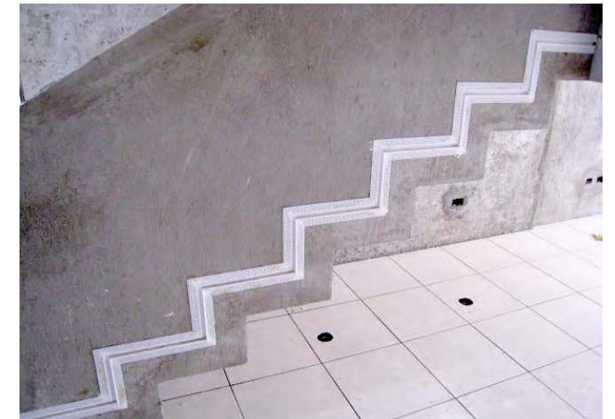
Entrecalle para Paneles de Yeso Estéticos e Intersección de la Entrecalle con un Angulo de 90° en la escalera
